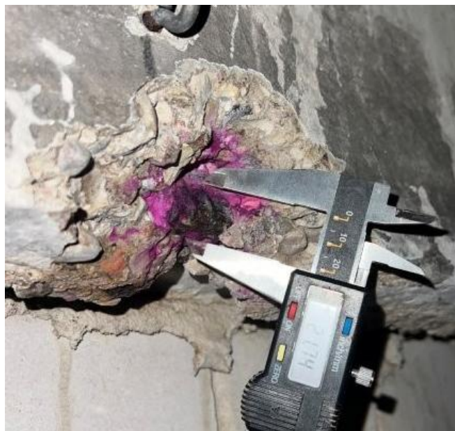
9 pav. Nustatytas denginio plokštės armavimas
