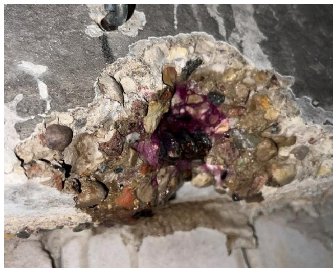
8 pav. Nustatytas denginio plokštės betono šarmingumas
